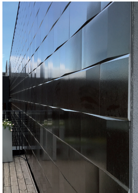
FIG. 8 Detalle del revestimiento cerámico
