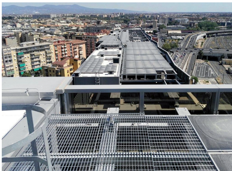
FIG. 9/ Instalaciones de energía solar en la cubierta
